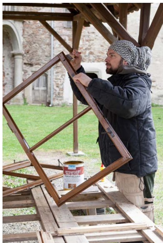
▲ Odborná repase okenních křídel hlavního sálu na zámku Brtnice. Foto Viktor Mašát
