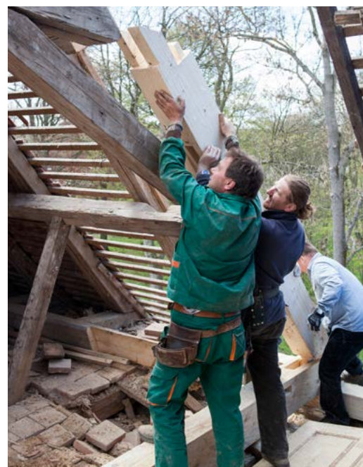
▲ Oprava krovu na zámku Brtnice. Výměna poškozených částí. Foto Viktor Mašát
