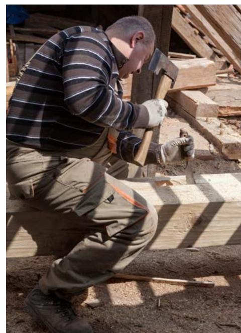
▲ Oprava krovu na zámku Brtnice. Opracování povrchu trámů. Foto Viktor Mašát
